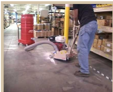
Sierra de grietas
